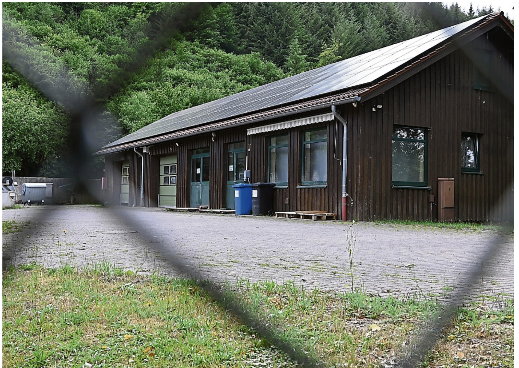
PV-Anlage spart Energiekosten: Auf dem Gebäude der Kläranlage Kirchlotheim ist Fotovoltaik installiert, die Energie wird direkt vor Ort genutzt.
