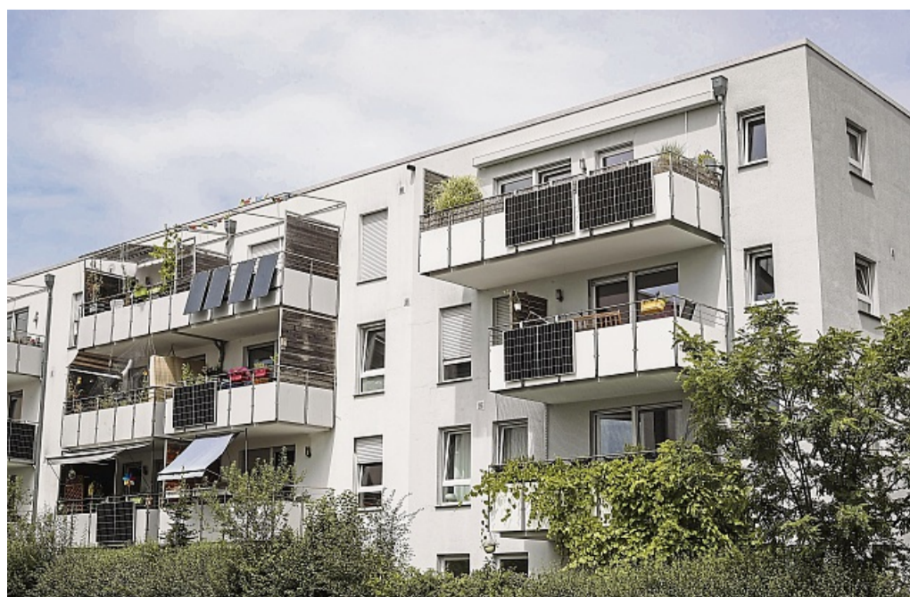
Vier Generationen teilen sich die insgesamt 24 Wohnungen: Die Bewohner sind zwischen zwei und 95 Jahren alt. FOTO: LEO SCHÖWERLING/DPA
