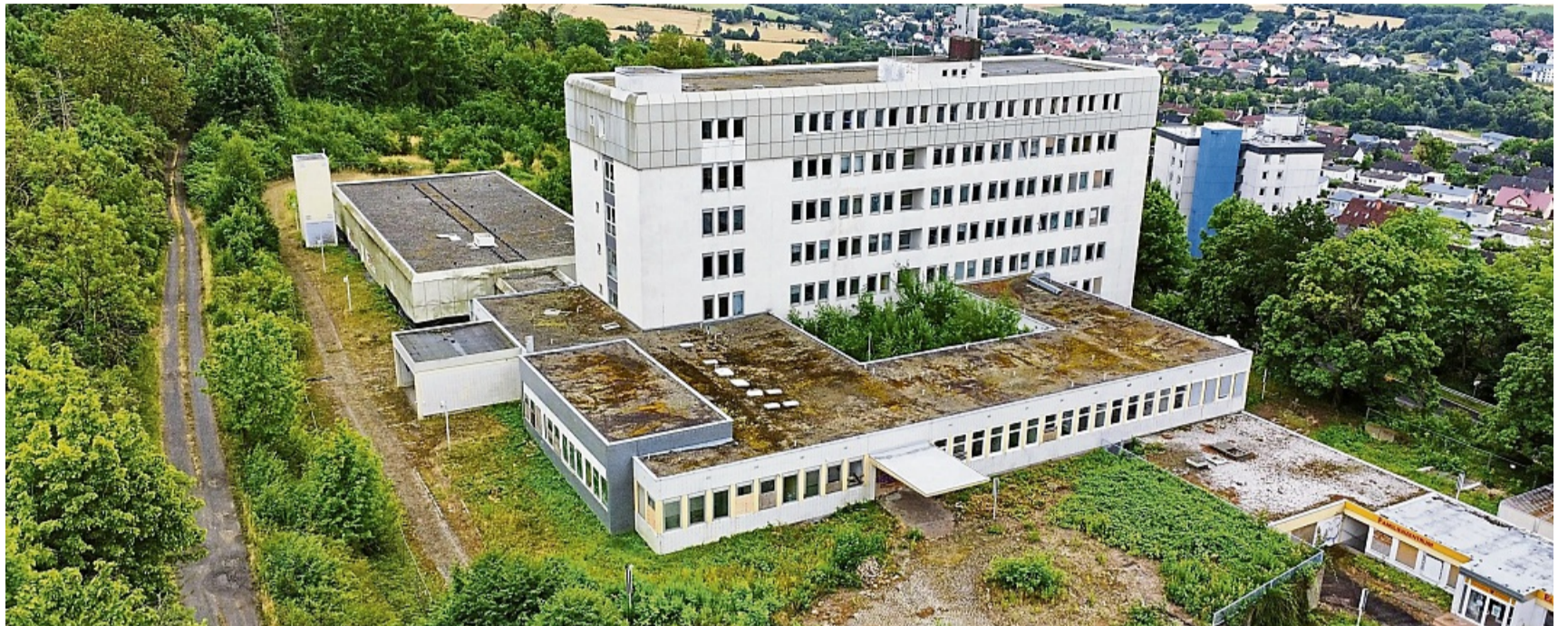
Die Planungen laufen: Während das Bettenhaus in der Bildmitte unbedingt erhalten werden soll, bereitet die Stadt den Abriss des OP-Trakts (hinten links) vor. FOTO: MAJA YÜCE
