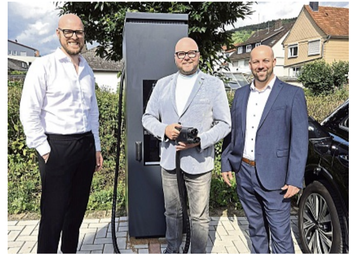
EAM errichtet Schnellladesäule in Morschen (von links): Nicolas Spengler, Roland Zobel, Christian Bambej FOTO: GEMEINDE MORSCHEN
