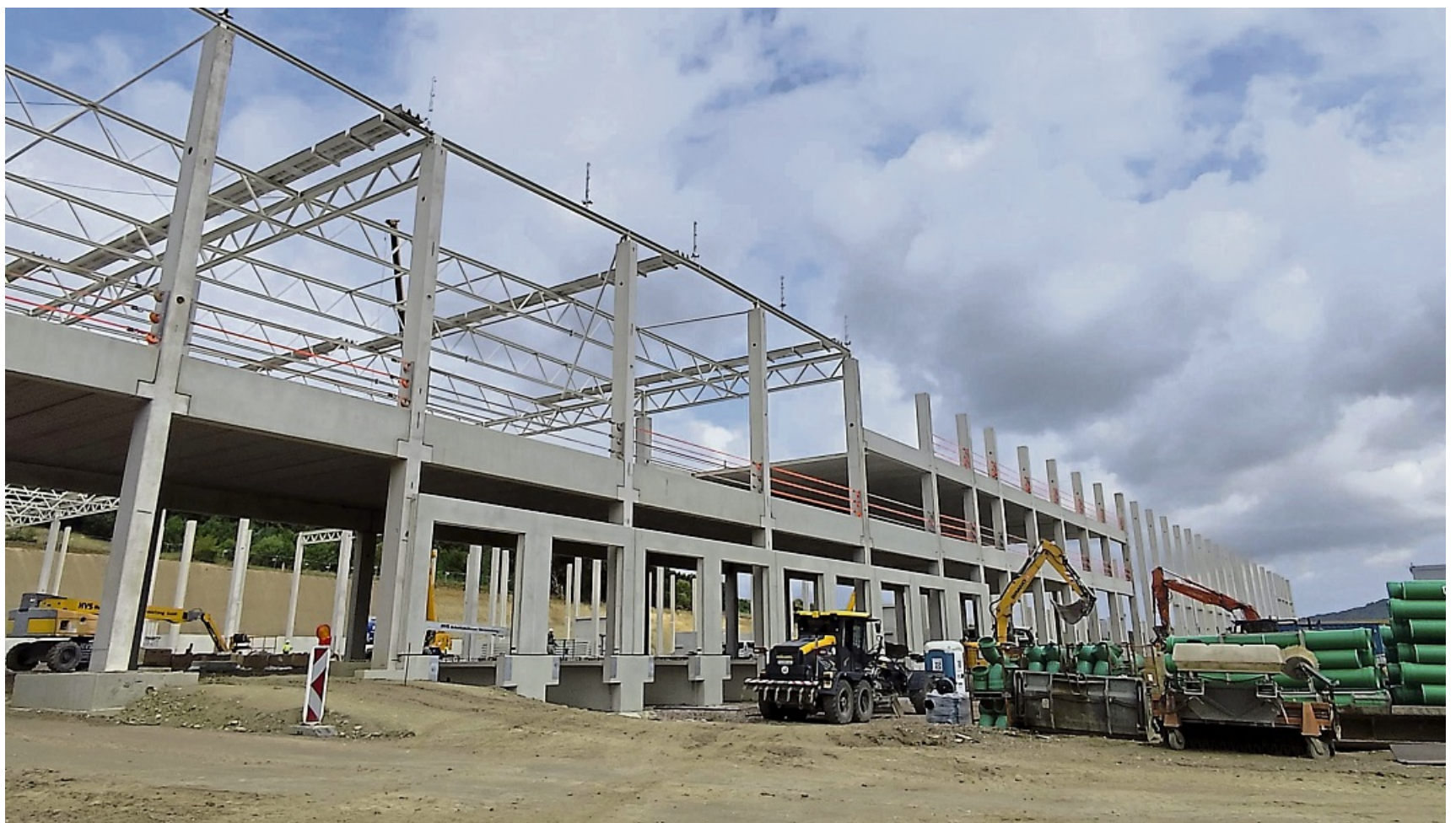
Soll im Frühjahr bezugsfertig sein: Das Bundeswehr-Logistikzentrum an der A 44 bei Breuna wird vor allem Geräte und Ersatzteile für das Heer beherbergen. FOTOS: MARTIN SCHOLZ
