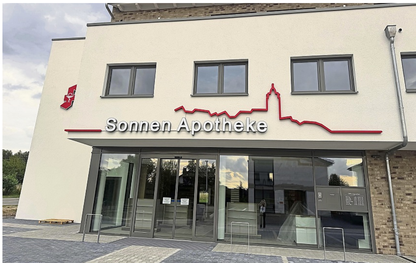
Neubau mit zwei Stockwerken: In dem Gebäude eröffnet neben der Apotheke auch eine Hausarztpraxis. Eine Heilpraktikerin und Hebamme praktiziert im Obergeschoss. FOTOS: BEA RICKEN
