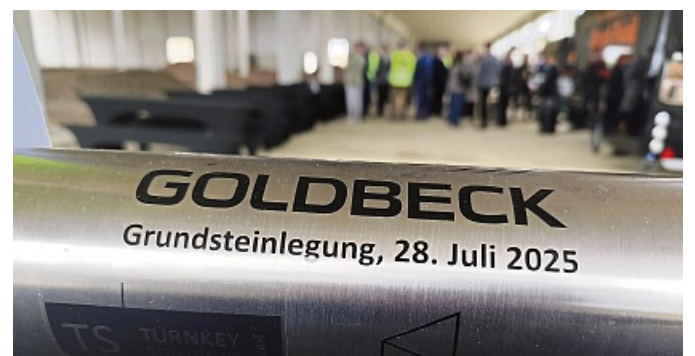
Inzwischen im Fundament versenkt: Die Zeitkapsel für das Bundeswehr-Logistikzentrum im Hiddeser Feld bei Breuna.
