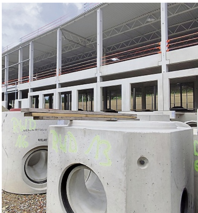
Der Rohbau ist fertig: Das Logistikzentrum wird weitestgehend klimaneutral gebaut.
