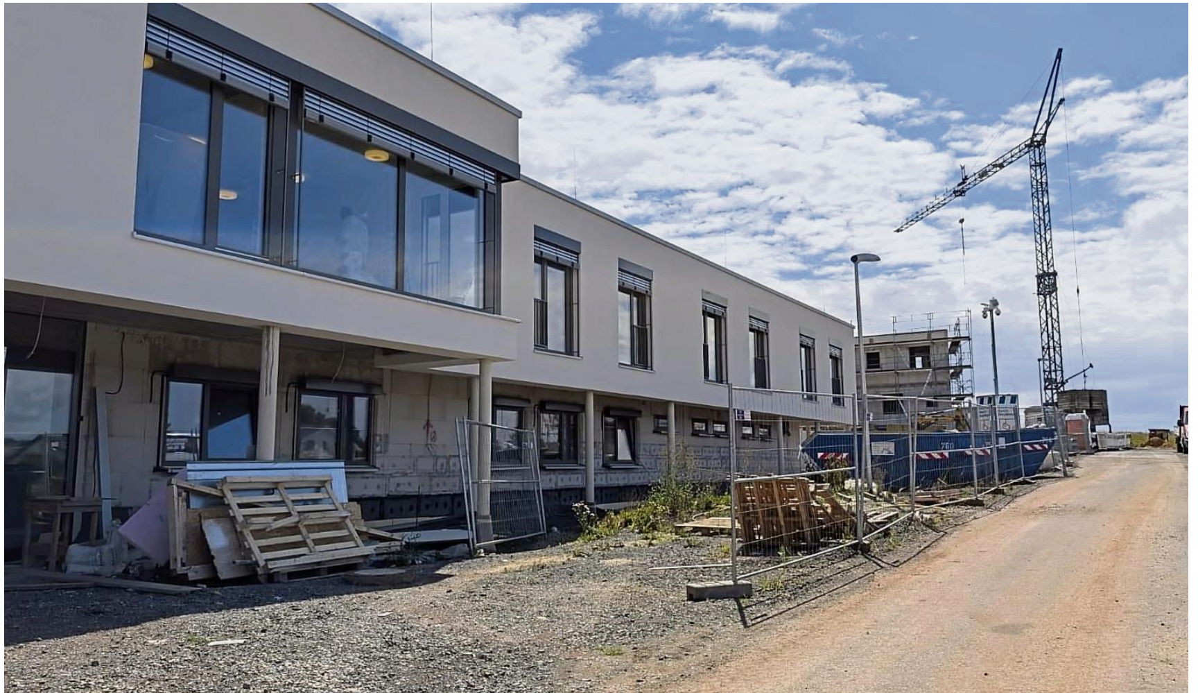
Die äußere Gebäudestruktur ist weitgehend fertiggestellt, im Inneren wird derzeit intensiv gearbeitet. Auch die Beleuchtung ist bereits angebracht.
