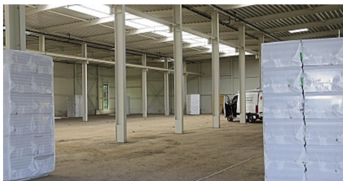
Neue Produktionshalle: Die ist aktuell noch voll im Bau. Fertigstellung soll voraussichtlich Ende des Jahres sein. FOTO: MJX
