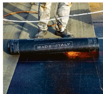
Flachdachsanieierung
