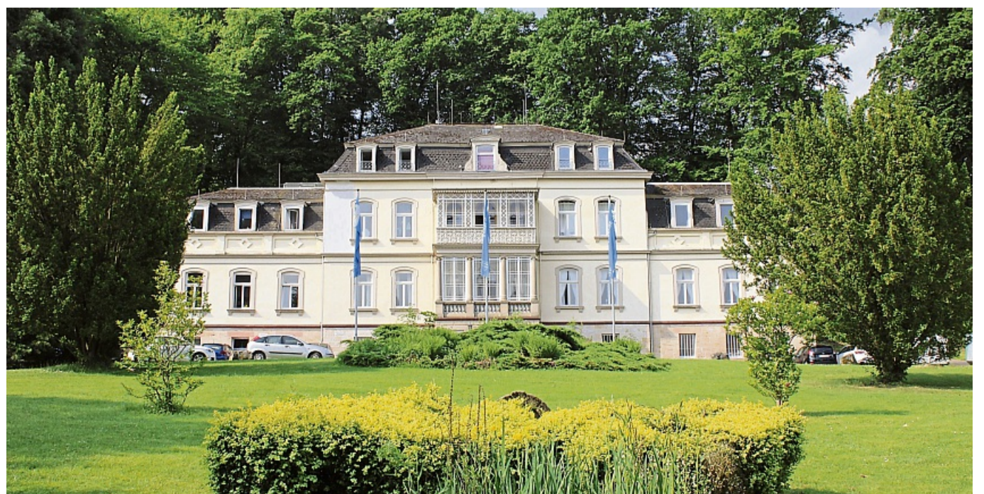
Das 1877 erbaute Schloss ist das prägnanteste Gebäude auf dem Gelände der Jugenddorf-Christophorusschule Oberurff.
