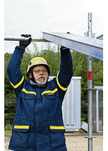
Hier packen alle mit an: Thomas Perleth beim Aufbau der Dekontaminationsschleuse.
