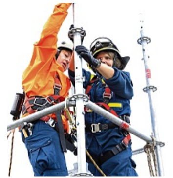
Gut gesichert: Helene Neufeld und Christina Dahnke setzen einen Eckpfosten.
