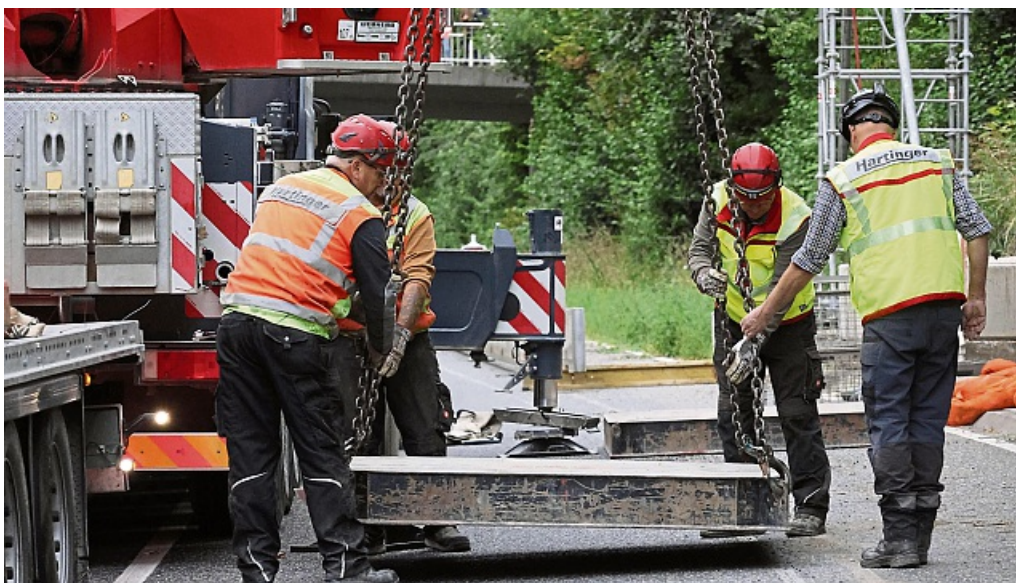
Kran-Stützen positionieren: Vier Stunden lang dauerten die Vorarbeiten, bis es endlich losgehen konnte.
