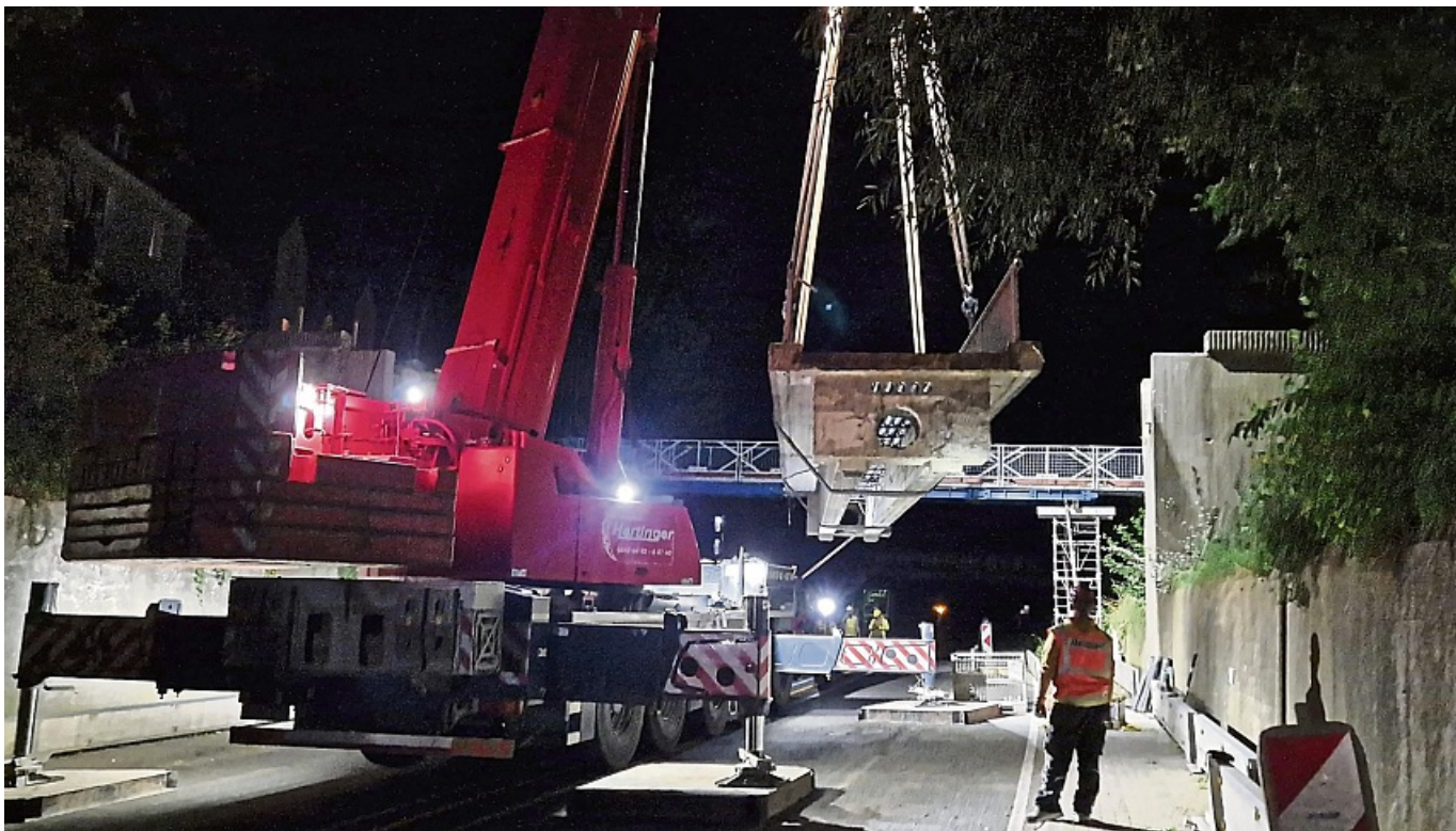
Geschafft: Die Seufzerbrücke wurde erfolgreich in 15 Minuten ausgehoben. Das 60 Tonnen schwere Bauwerk wird nun recycelt. Spätestens im Mai 2026 soll die neue Brücke eingebaut werden, kündigt Hessen Mobil an.
