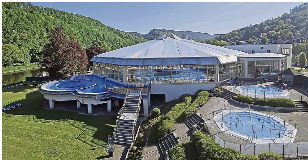
Weser-Therme mit neuer Lüftung und frischem Glanz.
