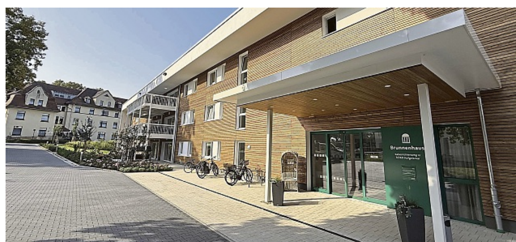
Einladend: Das neue Herzstück auf dem Gelände der Ev. Altenhilfe Gesundbrunnen in Hofgeismar wurde mit Leben gefüllt. FOTO: EV. ALTENHILFE GESUNDBRUNNEN / REPRO: GITTA HOFFMANN
