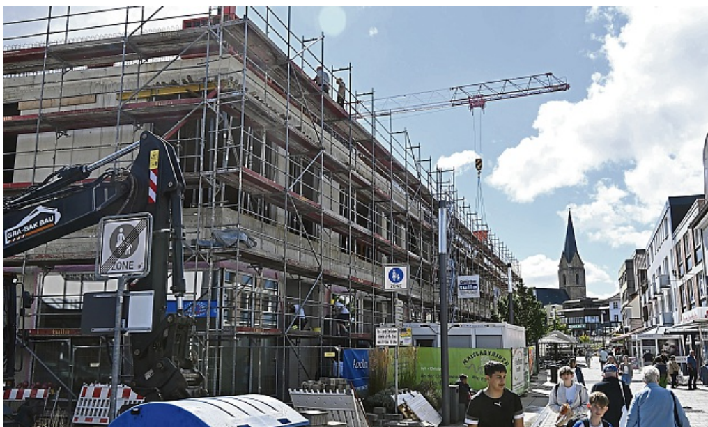
Das Ende der Fahnenstange ist noch nicht erreicht: Auf die oberste Betondecke kommt noch ein zweigeschossiger Holzbau.
