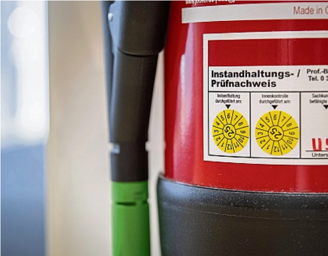
Instandhaltungs- und Prüfnachweise: Der Feuerlöscher darf nicht zu alt sein – eine regelmäßige Wartung ist wichtig.
