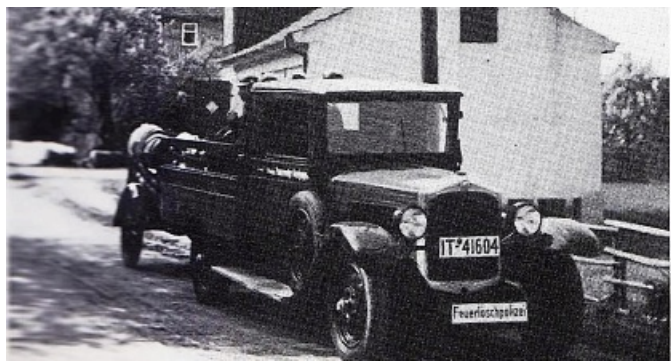
Das Feuerwehrgerätehaus in Guxhagen wurde um 1938 aufgestockt und beherbergte auch den Kindergarten.
