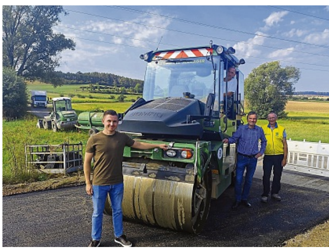
Frisch und glatt: Jannick Schade vom Wolfhager Tiefbauamt (von links), Bauarbeiter Björn Eggerstorff (am Steuer), Wolfhagens Bürgermeister Dirk Scharrer und Roger Stanislawski von der Rad AG am neuen Radweg in Richtung Glockenborn. FOTO: MARTIN SCHOLZ
