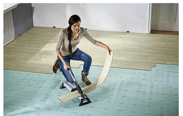
Nach der Trittschalldämmung kommt der Bodenbelag – wer ihn Zuhause selbst verlegen will, sollte vorgesehene Dehnungsfugen einplanen.
