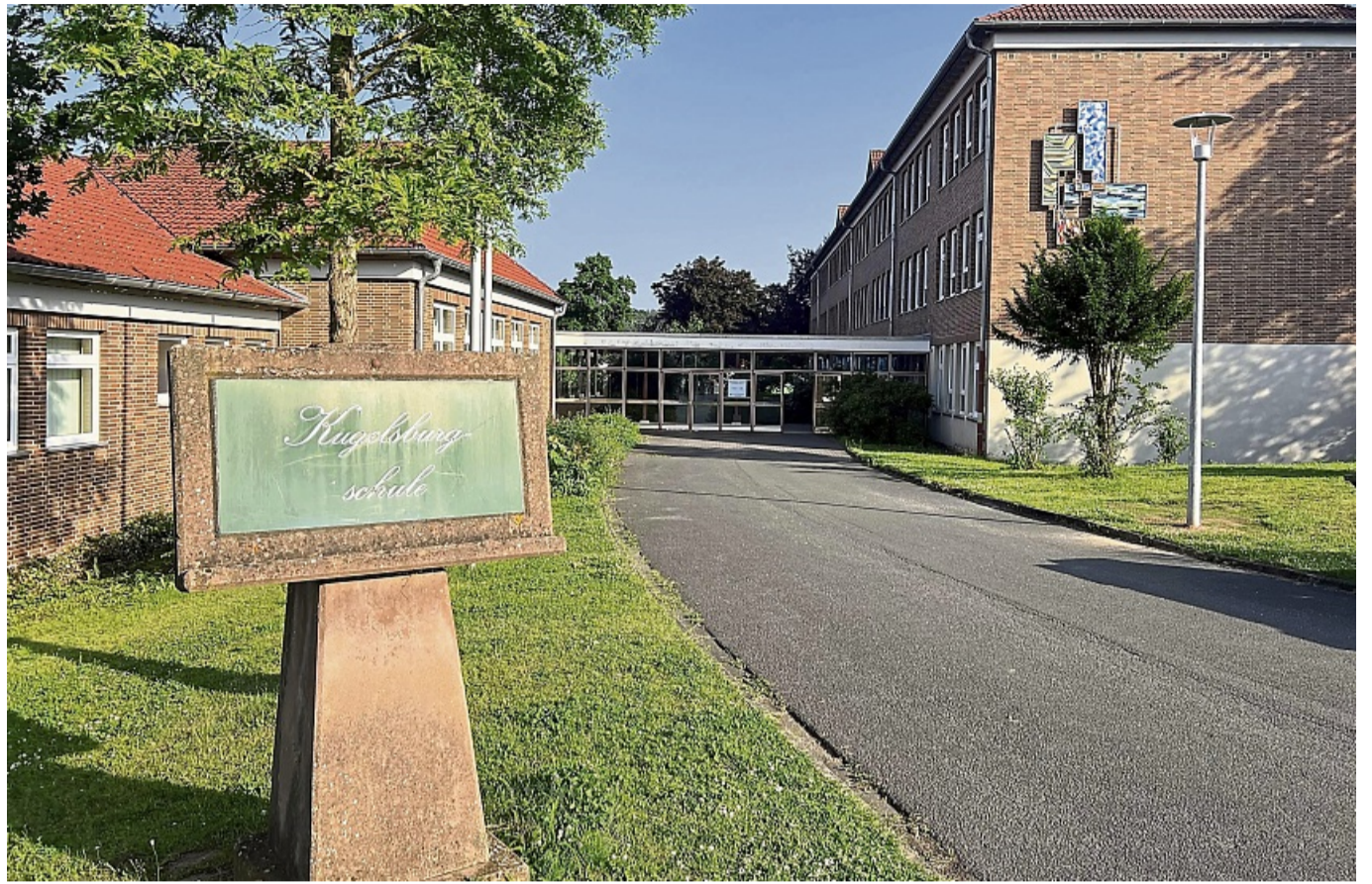
Ein Neubau der Kugelsburgschule ist nötig, die Haushaltsmittel für die Planung sind aber noch gesperrt. ARCHIVFOTO: SCHULTEN
