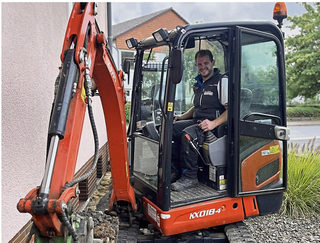
Lucas Hildebrand legt ein Haus frei zur nachträglichen Gebäudeabdichtung.
