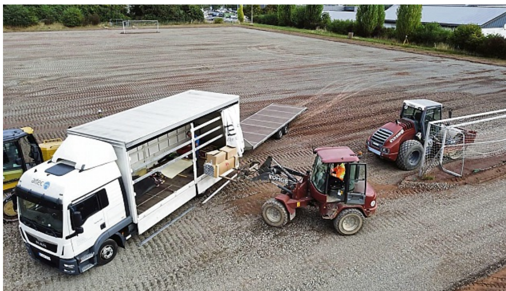
Seit dieser Woche rollen die Baumaschinen an der August-Gerhold-Kampfbahn am Stiegweg in Zierenberg. Der alte Hartplatzbelag wird abgeschoben und seitlich gelagert.
