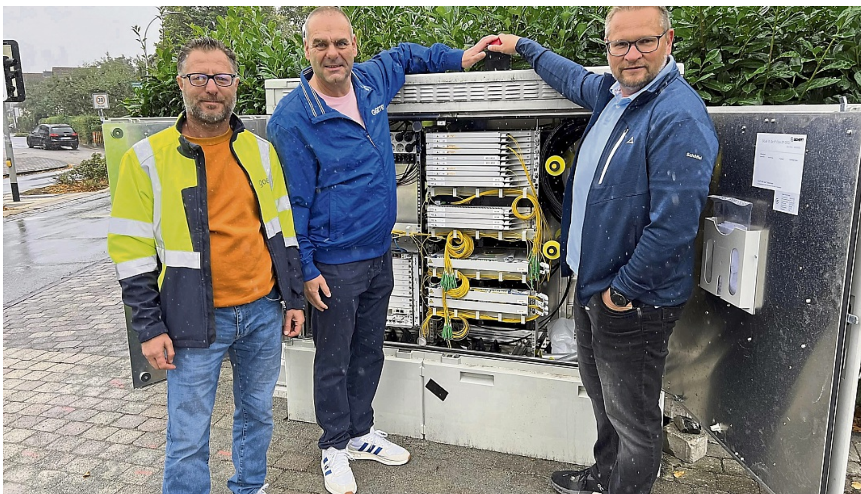
Anschlussarbeiten laufen: (von links) Serdar Cira (Bauleiter Goetel), Andreas Pioch (Kommunalbetreuer Goetel) und Swen Wagner (Bauamt Habichtswald).
