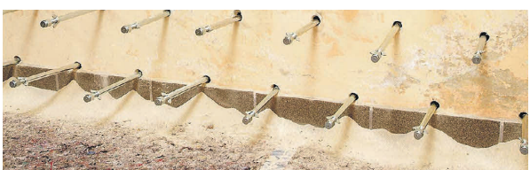
Kellerabdichtung durch Injektion
