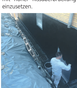
Kellerabdichtung von außen
