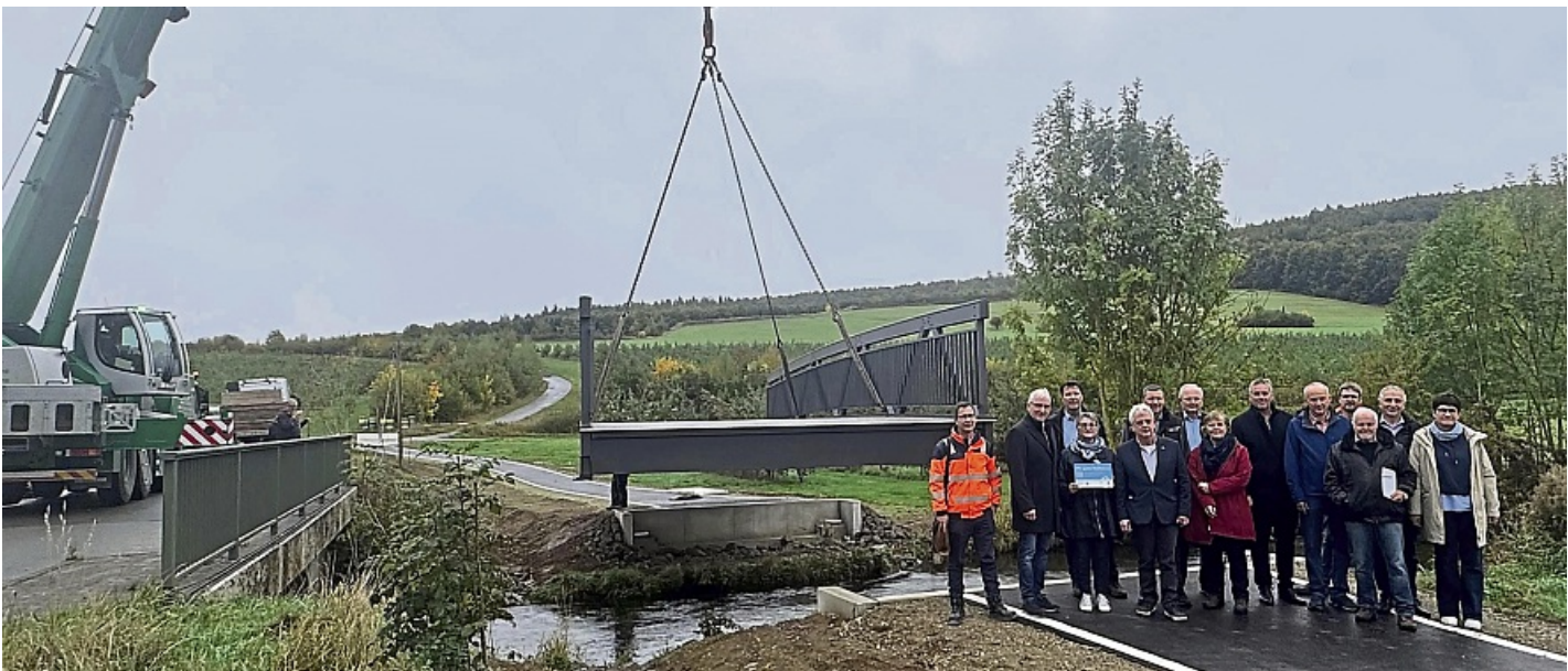
Zwischen der Landesgrenze zu Nordrhein-Westfalen und dem Gut Billinghamen in Diemelstadt erlebten Vertreter von Landkreis und Diemelstadt den Einbau großer Brückenbauteile. FOTOS: LANDKREIS WALDECK-FRANKENBERG
