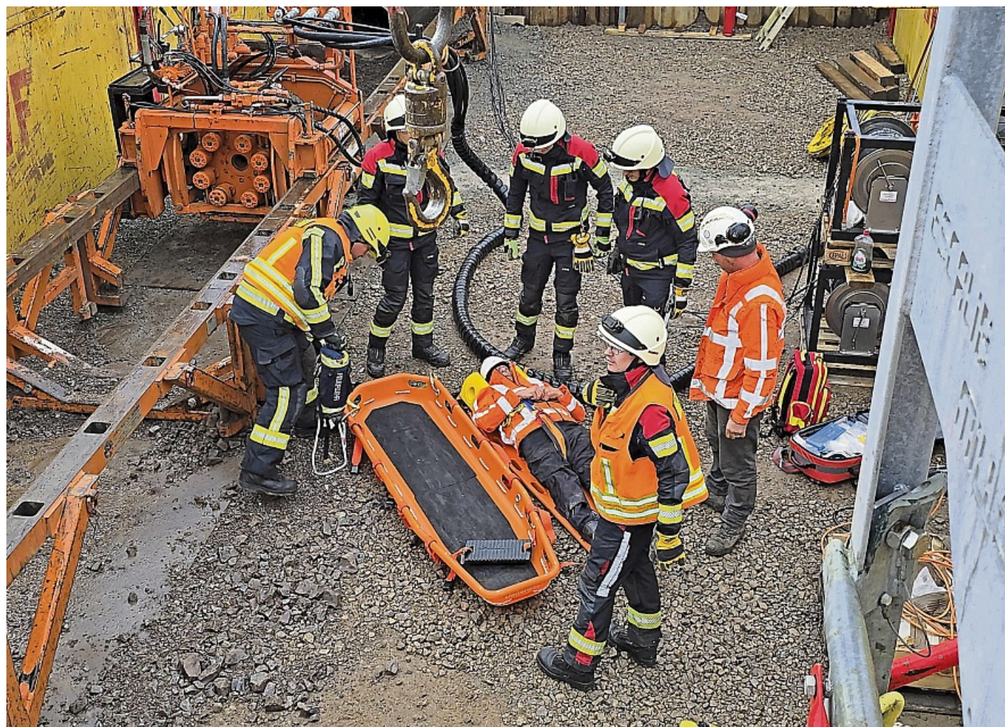
Vorbereitung für den Transport: Die Feuerwehrleute haben den Verletzten auf das Tragebrett gebunden. Der Mann war in der Startgrube für eine Erdbohrung von einem herabstürzenden Balken schwer am Bein verletzt worden.
