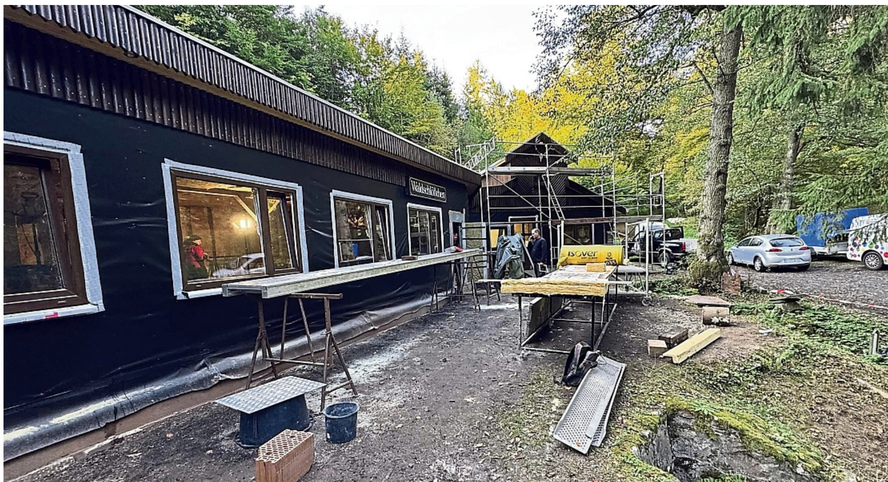
Während der Bauarbeiten leuchtet das Licht wieder im Gebäude: Im ehemaligen Ausflugslokal Waldschlösschen im Fahrbachtal bei Großalmerode wird seit Monaten kräftig gearbeitet.
