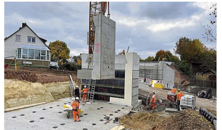
Millimeterarbeit: Langsam, ganz langsam wurde das vorgefertigte Bauteil eingepasst.
