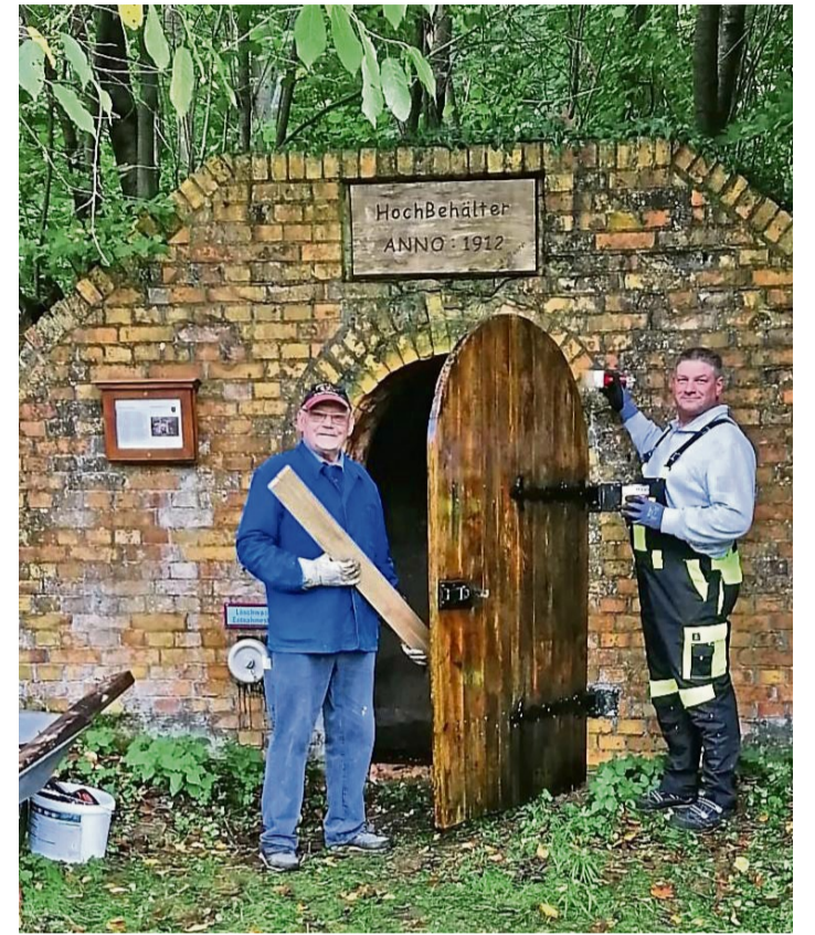
Renovierungsarbeiten: Walter Zeleny und Karl Heinz Köhler (Foto) sowie Ortsbürgermeister Fred Kaduhr renovierten die Eingangstür des alten Wasserhauses in Speele.
