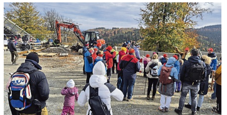
Zur Baustelle des Mühlenkoppliners führte die Herbstwanderung des Ski-Club Willingen. FOTO: SKI-CLUB WILLINGEN
