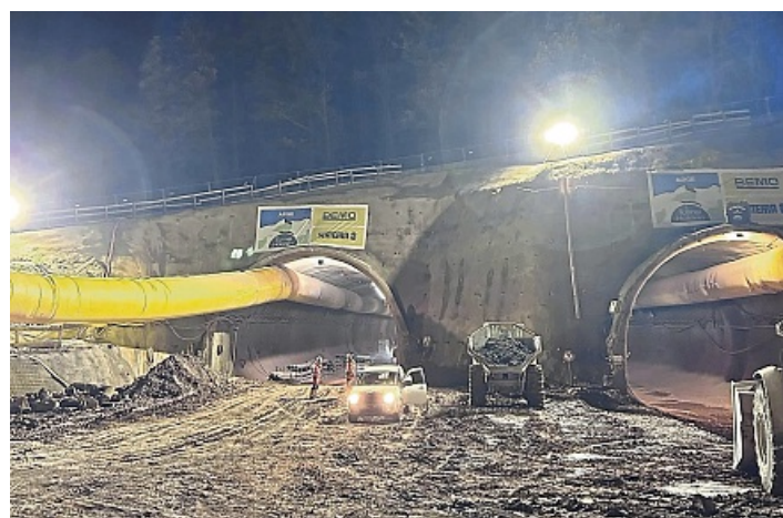
Blick auf die Baustelle am Tunnel Hollstein.
