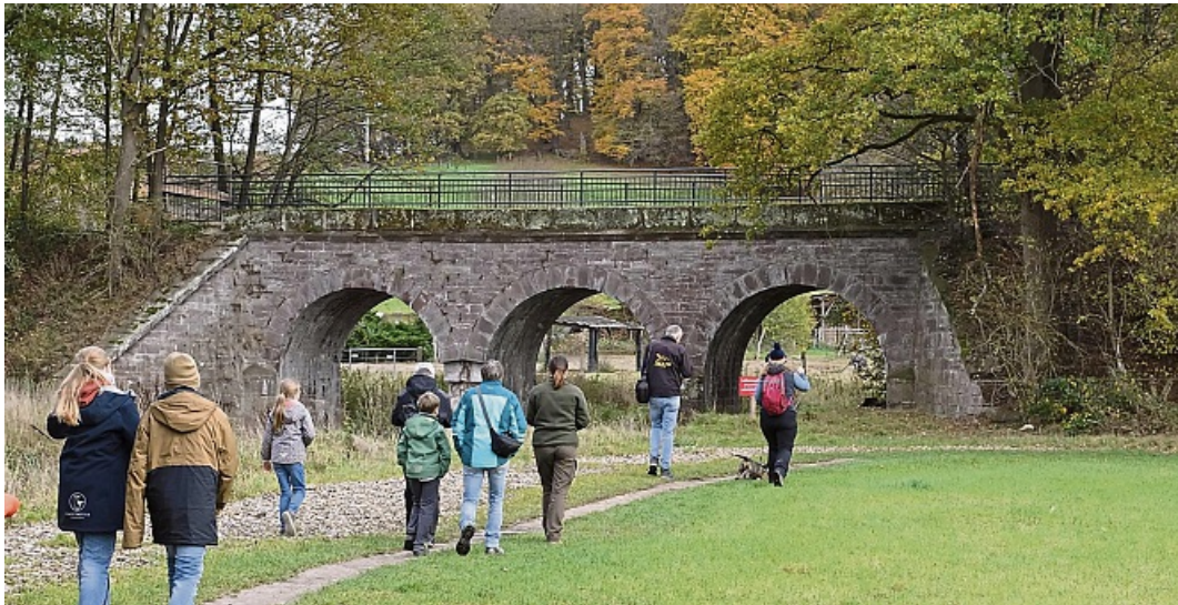
Besucher der Fledermausführung passierten auf dem Weg zum Tunnel auch die gesperrte Bahn- und Radwegbrücke.
