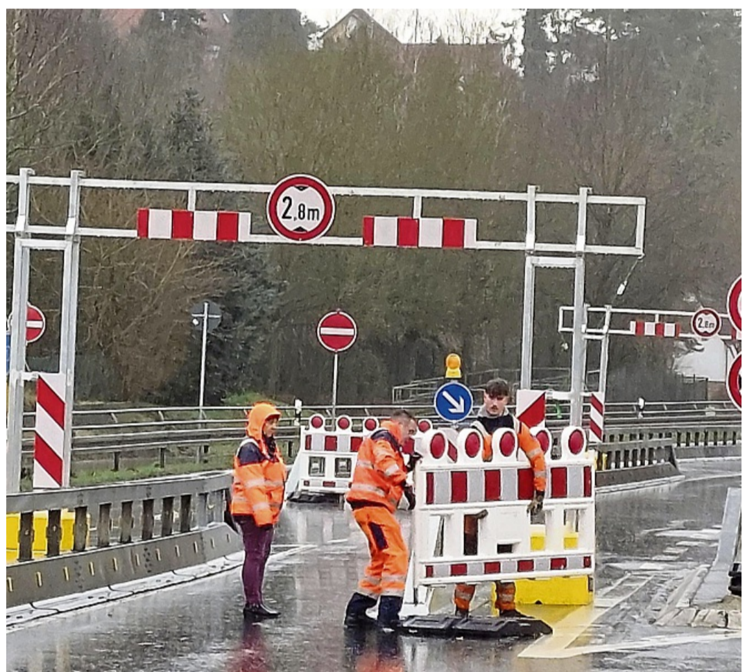
Häufig beschädigt: die Höhen- und Breitenbegrenzung auf der Straße zwischen Hertingshausen und Grifte. Nach einem Unfall im Januar war eine Vollsperrung notwendig. Der Verkehr wurde dann über Holzhausen/Hahn umgeleitet. ARCHIVFOTO: MARCO LINGEMANN/HESSEN MOBIL
