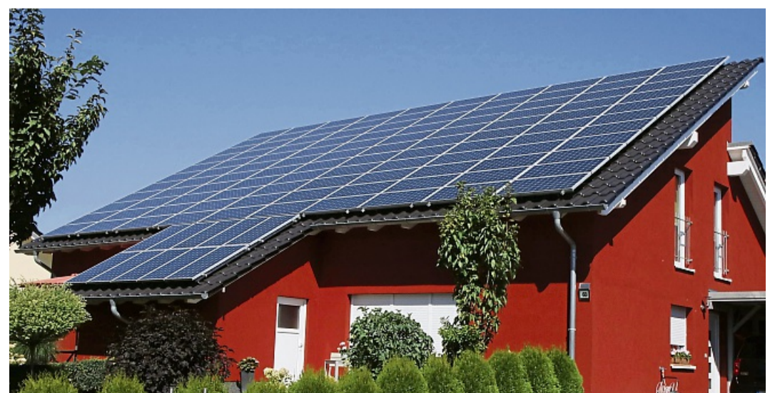
Wer Strom aus seiner Photovoltaikanlage ins Netz einspeist , kann sich über eine Einspeisevergütung freuen – vorausgesetzt, die Anlage ist korrekt angemeldet.
