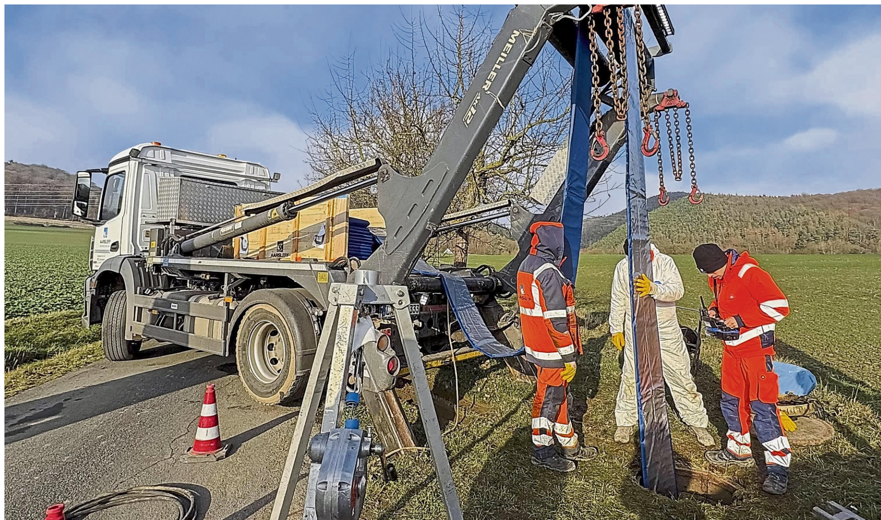
Die Edertaler Gemeinde saniert die Kanäle in neun Ortsteilen umfassend.
