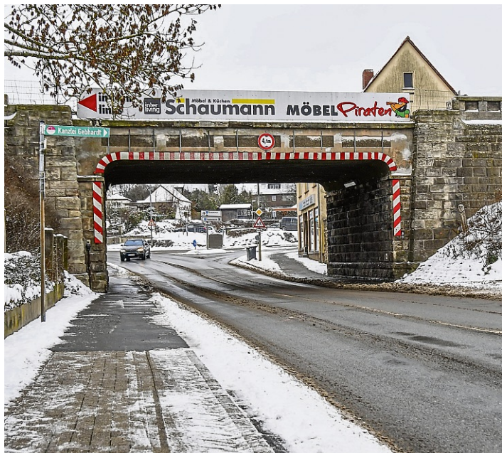
Die Bahnunterführung zwischen dem Kreisel und dem Abzweig zur Friedrichstraße soll in den nächsten Jahren komplett abgerissen werden.
