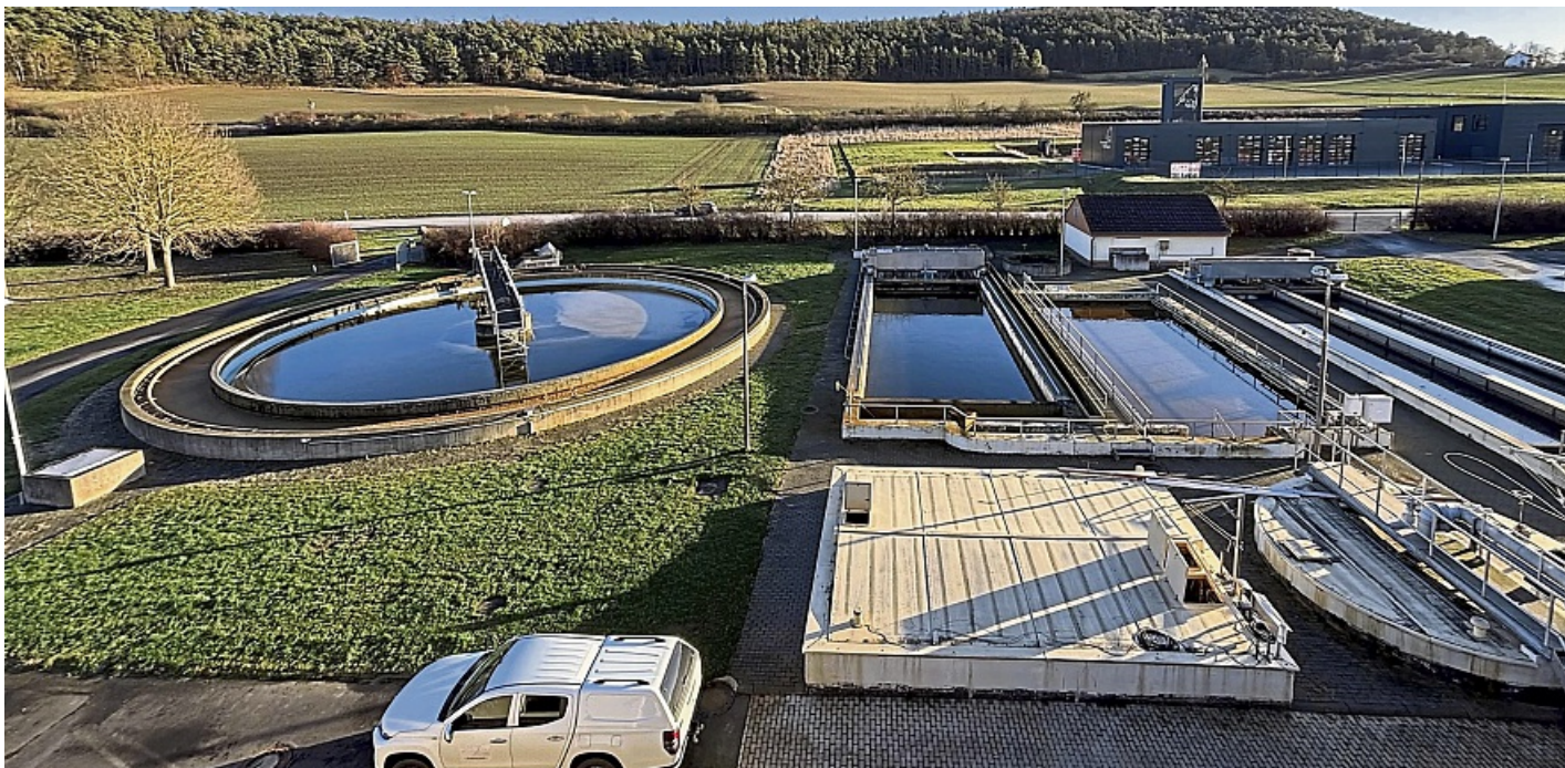
Wolfhagens Klärwerk muss in den kommenden Jahren modernisiert und ausgebaut werden. Die im Wasser enthaltene Energie könnte für den Betrieb einer Groß-Wärmepumpe genutzt werden. Die ist aktuell Gegenstand der Wärmeplanung für Wolfhagen. Das Foto zeigt mehrere Klärbecken.
