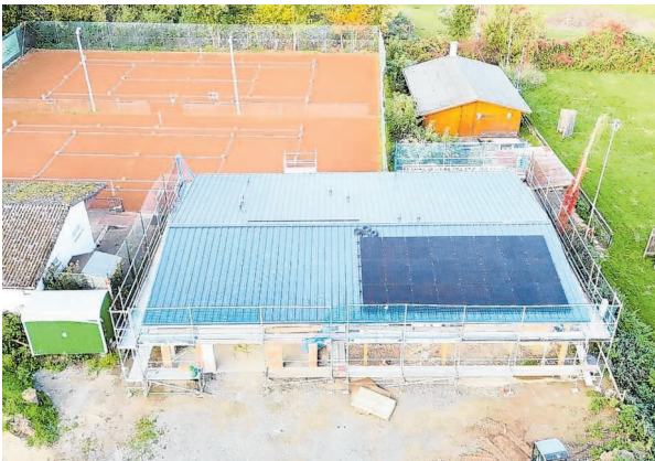
Das Vereinsheim des FC Eintracht Polle befindet sich momentan im Rohbauzustand. Die Höchstförderung von 25.000 Euro durch den Klima.Sieger macht die umfassende Modernisierung möglich.
