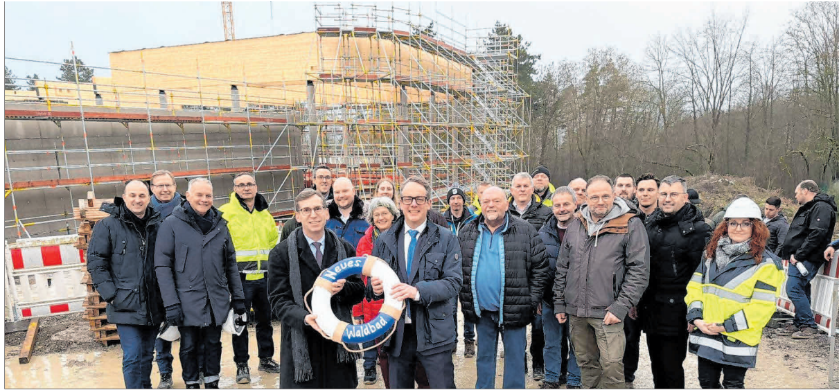
Das Neue Waldbad feiert Richtfest: Bürgermeister Tobias Scherf (vorne links) und Stadtwerke-Geschäftsführer Leander Sasse, die Mitglieder des Rates und die Bauverantwortlichen freuen sich über diesen wichtigen Meilenstein.
