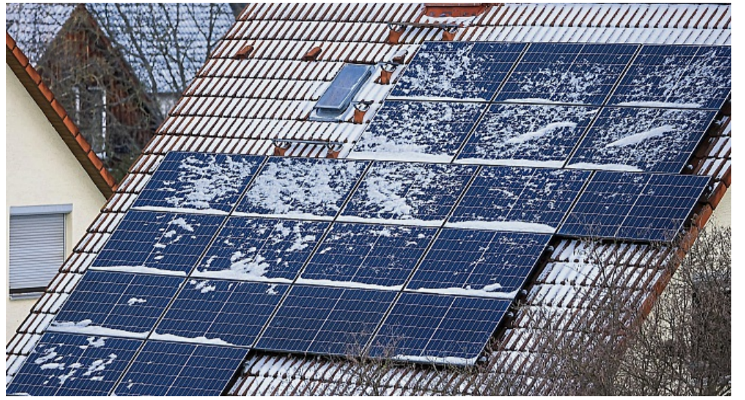
Wenn der Schnee taut: Jetzt Dachziegel, Rinnen und Anschlüsse kontrollieren.
