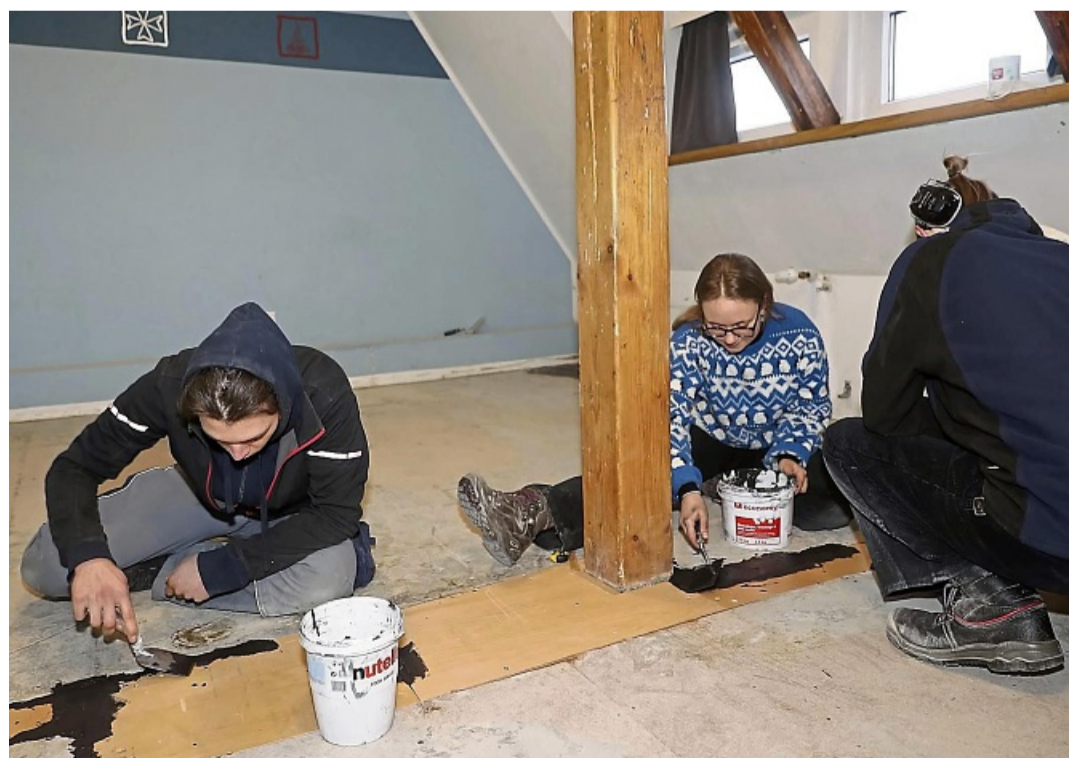
Im Mittelbau der Burg beteiligten sich Julian Melzer (von links), Nele Wustmans und Thomas Schröttke an der Erneuerung des Fußbodens.
