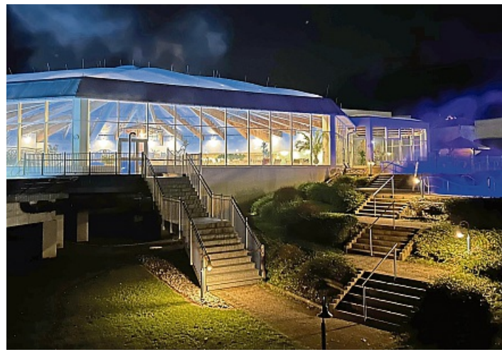
Die Wesertherme in Bad Karlshafen: Hier ist der Winterbetrieb schon fast Routine.
