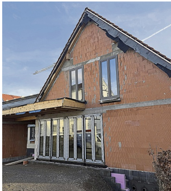
Nicht mehr wiederzuerkennen: Das Rhoder Gemeinschaftshaus mit seiner neuen Dachlandschaft.
