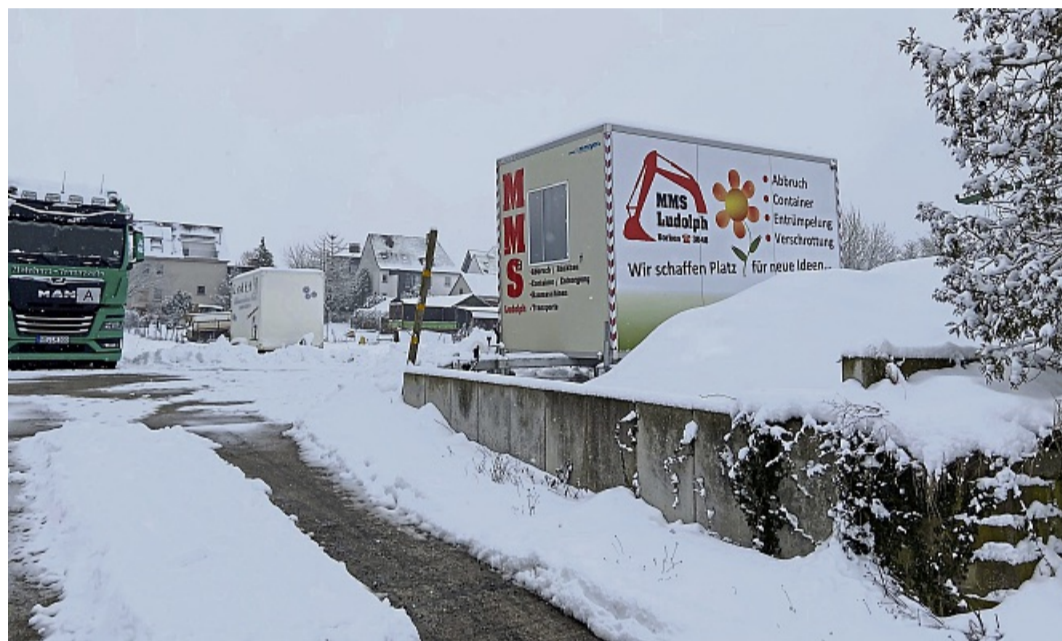
Wird schon entrümpelt: Das Gelände der ehemaligen Gärtnerei Ochs in Borken wird derzeit schon leer geräumt. FOTO: CORA ZINN
