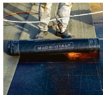
Flachdachsanieierung
