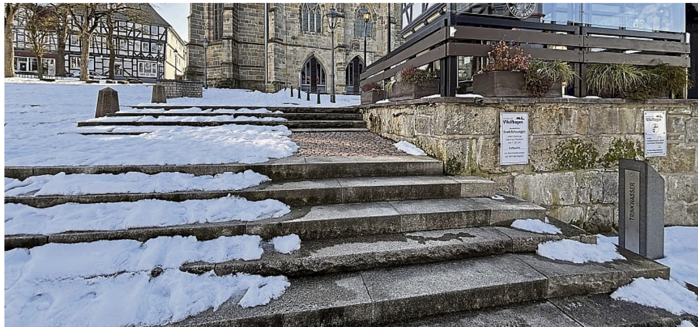
Das Fehlen eines Geländers an der Treppe zum Café Alte Wache am Marktplatz in Wolfhagen bemängelt Wolfhagen Hensel, Behindertenbeauftragter in Wolfhagen.
