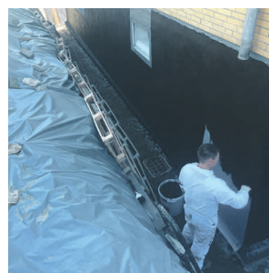
Kellerabdichtung von außen
