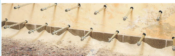
Kellerabdichtung durch Injektion
