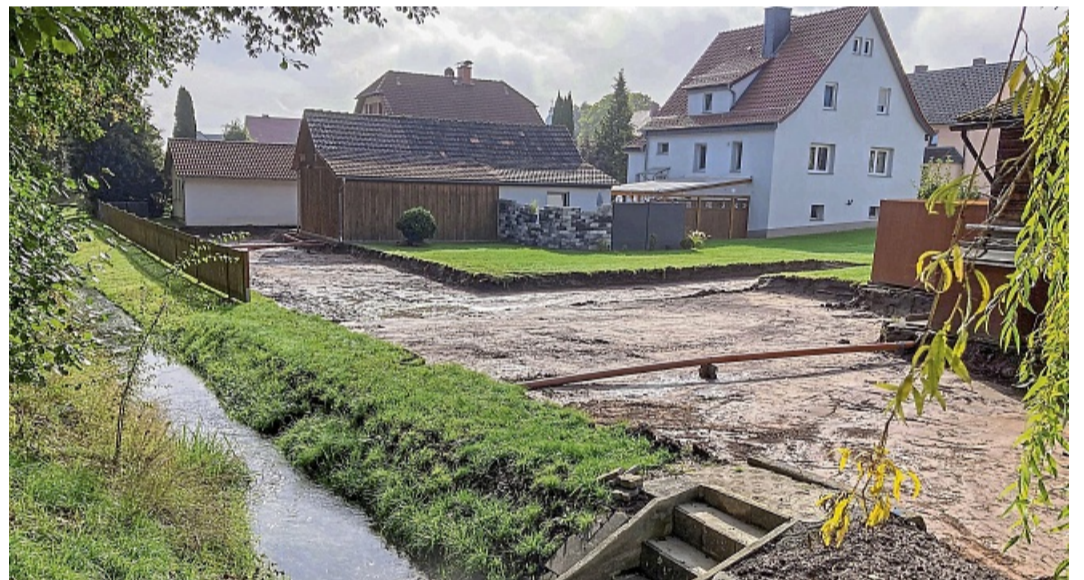
Die Weihe in Richelsdorf: Entlang des Bachs lagen auch private Grundstücke, die im Zuge der Altlastensanierung von belastetem Boden befreit wurden. FOTO: RENE DUPONT
