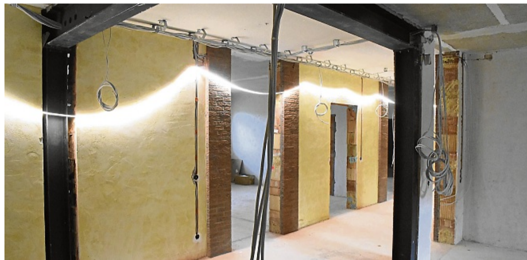
Umbau im Verwaltungstrakt: Dieses ehemalige Zimmer des Bauamts (rechtes Bild) wird in zwei Räume aufgeteilt. Rechts entsteht ein WC, links wird ein Besprechungsraum für den Trausaal geschaffen. Alle Räume wurden entkernt (linkes Bild), unter anderem wird die Elektrik erneuert. Vorn rechts soll ein Info-Point mit Empfangstheke entstehen.
