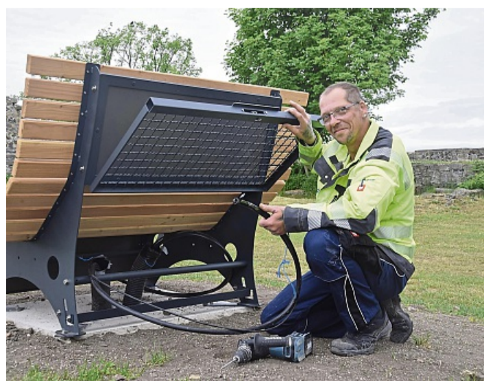
Kümmert sich um die Technik: Monteur Wesley Smit hat mit Kollegen 1000 Meter Stromkabel verlegt. Die führen unter anderem zu einer neuen Sitzbank, unter der einer der Strahler versteckt wird. FOTO: CHANTAL MÜLLER
