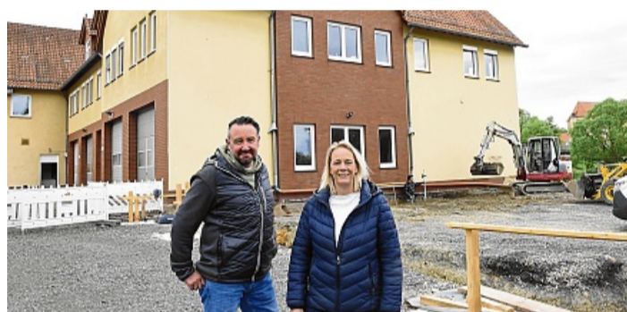
Freuen sich über den guten Baufortschritt: Bauamtsleiter Steffen Tasler und Bürgermeisterin Susanne Schneider an der Baustelle, auf der Arbeiter der Firma Planbau Kreuzebra aus Dingelstädt den Baugrund für den Hochbau vorbereiten (im Hintergrund). Der Anbau wird unmittelbar an die Fassade des Rathauses bis zur Firsthöhe anschließen.
