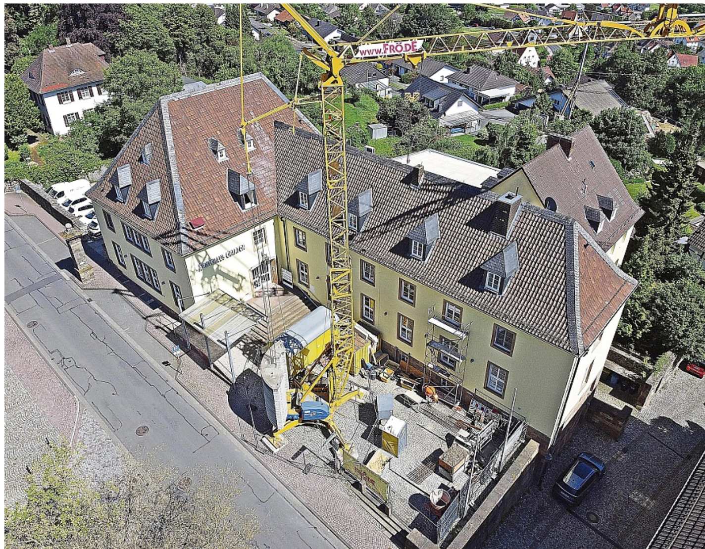
Soll barrierefrei werden: Im Ärztehaus am Obertor läuft derzeit der dritte Bauabschnitt.
