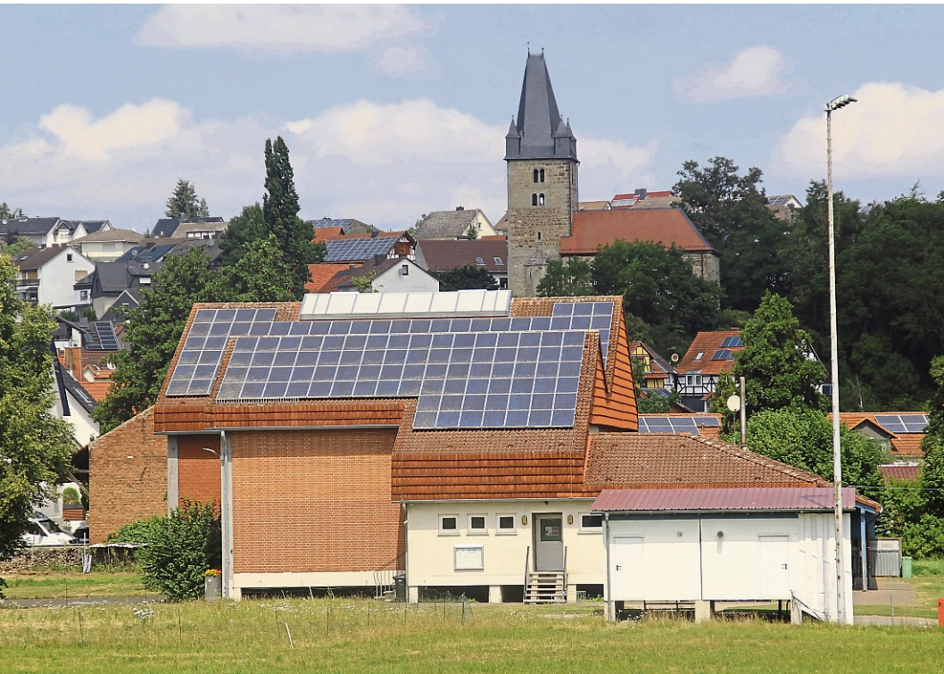
Die Sonne schickt keine Rechnung: Blick auf die Photovoltaikanlage der städtischen Gymnastikhalle am Sportplatz Neuenbrunslar.
