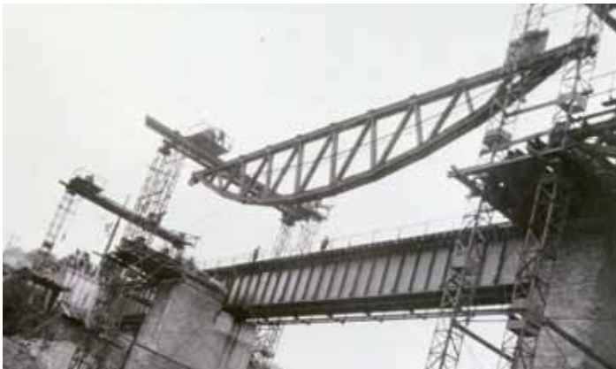
Ein Fischbauchträger wird aus dem Kanonenbahn-Gleis gehoben. Auf dem Heiligenstädter-Gleis ist der Brückenpfeiler mit neuen Lagern zu sehen.
