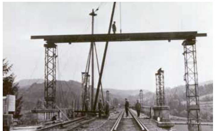
Umbauarbeiten vor dem nordwestlichen Widerlager. Im Hintergrund kann man ganz links noch den Hülfsberg erkennen.
