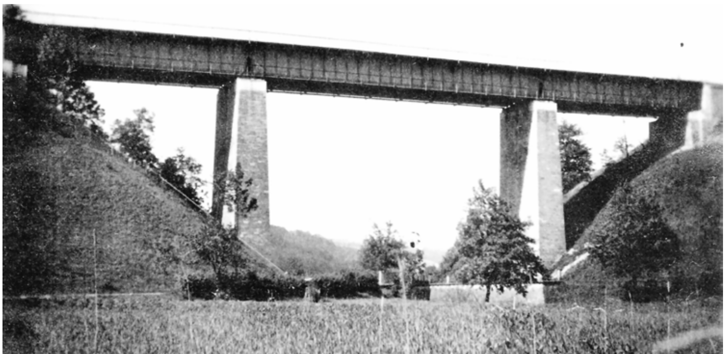
Im August 1932 waren die Umbauarbeiten am Frieda-Viadukt abgeschlossen.
