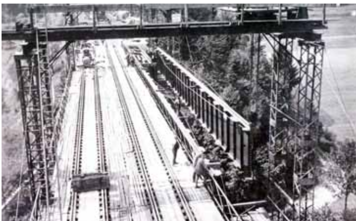
Vor dem nordwestlichen Widerlager wird ein neues Seitenteil für das Heiligenstädter-Gleis eingebaut.
