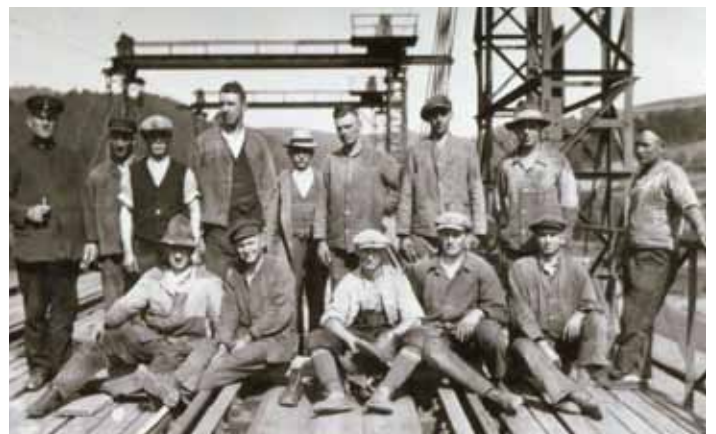
Nach getaner Arbeit stellte sich ein Großteil der Arbeiter, die am Umbau beteiligt waren, dem Fotografen. Alle Fotos: Archiv Heimatverein Frieda
