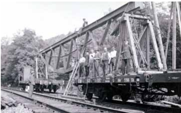
Ein herausgehobener Fischbauchträger wurde auf zwei Güterwagen verladen und ist fertig für den Abtransport.
