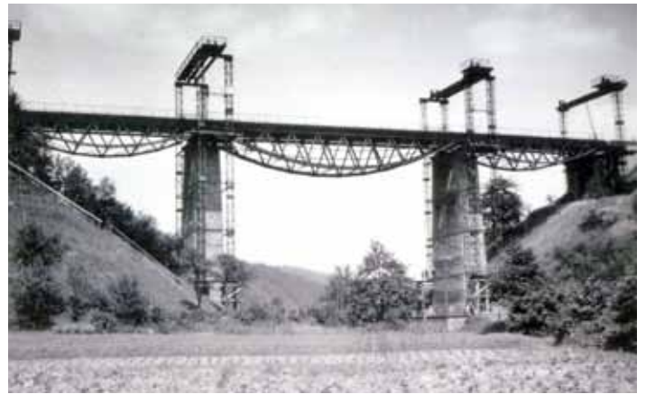
Alle vier Gerüste mit den Flaschenzügen für den Brückenumbau sind fertig aufgestellt.
