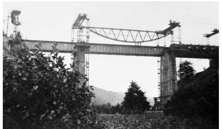
Die gleiche Situation mit dem Ausbau des letzten Trägers wird auch von unten her gezeigt. Hierbei handelt es sich um den breiten Mittelträger.
