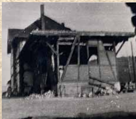
Der Bahnhof wurde mehrfach getroffen und dadurch schwer beschädigt.
