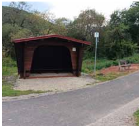
Radfahrer und Wanderer können ab sofort an dieser Hütte, direkt an der »Weißen Brücke« eine kleine Rast einlegen.
