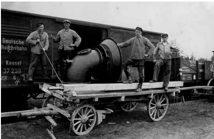
Ausladen der Turbine am Bahnhof
