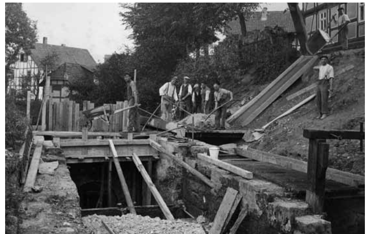
Arbeiten am Turbinenschacht
