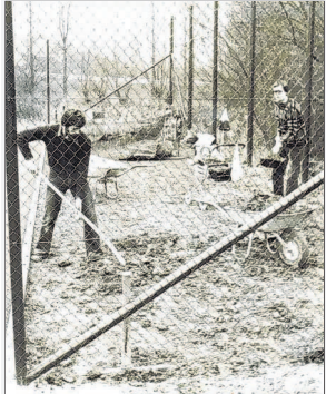
Bau des 1. Tennisplatzes.
