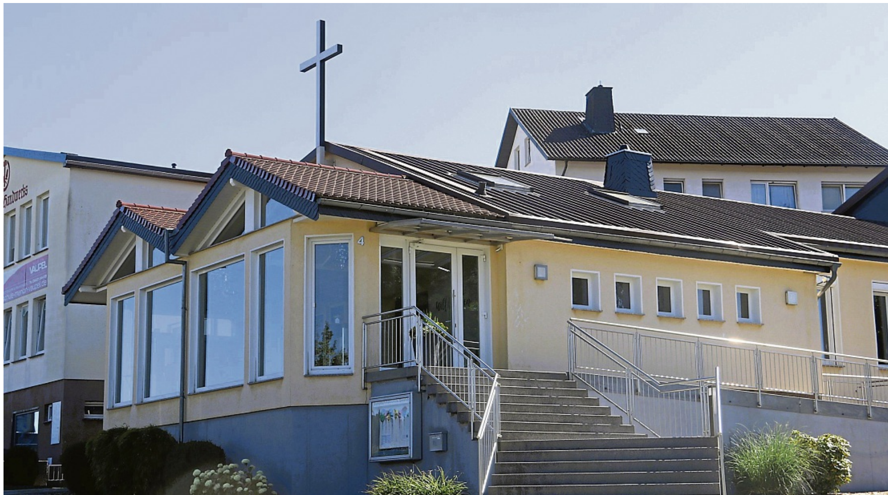
Kirche am Bahnhof: 1961 wurde das Gemeindehaus in der Friedrichstraße 4 in Frankenberg gebaut, anschließend wurde es ständig erweitert.
