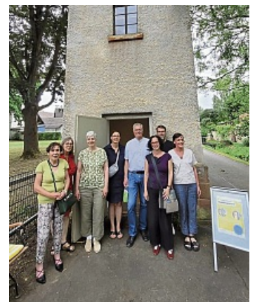
Die Veranstaltungsreihe „Hereinspaziert“ führte zum ehemaligen Trafohäuschen in Niederurff.
