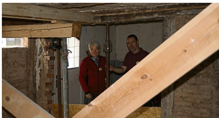
Es tut sich was: In der Bauruine haben Christian und Monika Reetz die ersten Balken verbaut.
